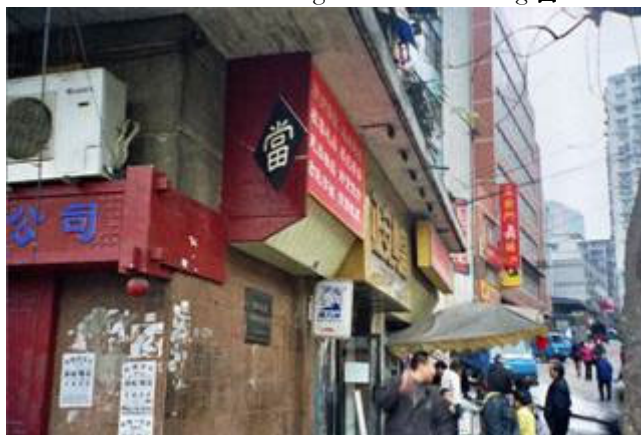
Photo 1. – Une enseigne au caractère dang 當
